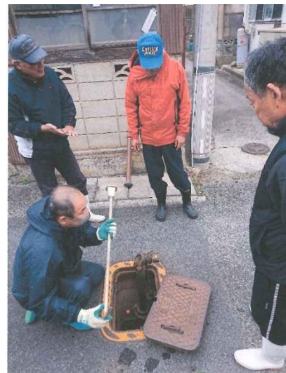
▲地区内消火栓の点検の様子
